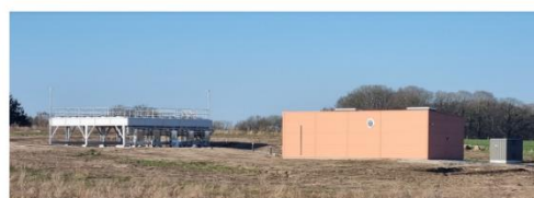
Laurbjerg Kraft Varmeværk
